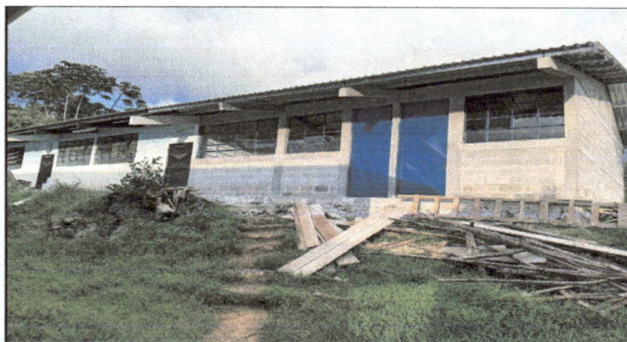
Foto 3: Colocación de puerta de metal de aula y dirección.
