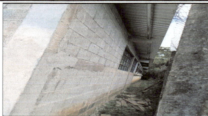
Foto 2: Repello de las columnas del nuevo aula.
