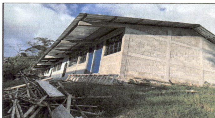
Foto 4: Colocación de ventanas con vidrios del nuevo aula y dirección.
